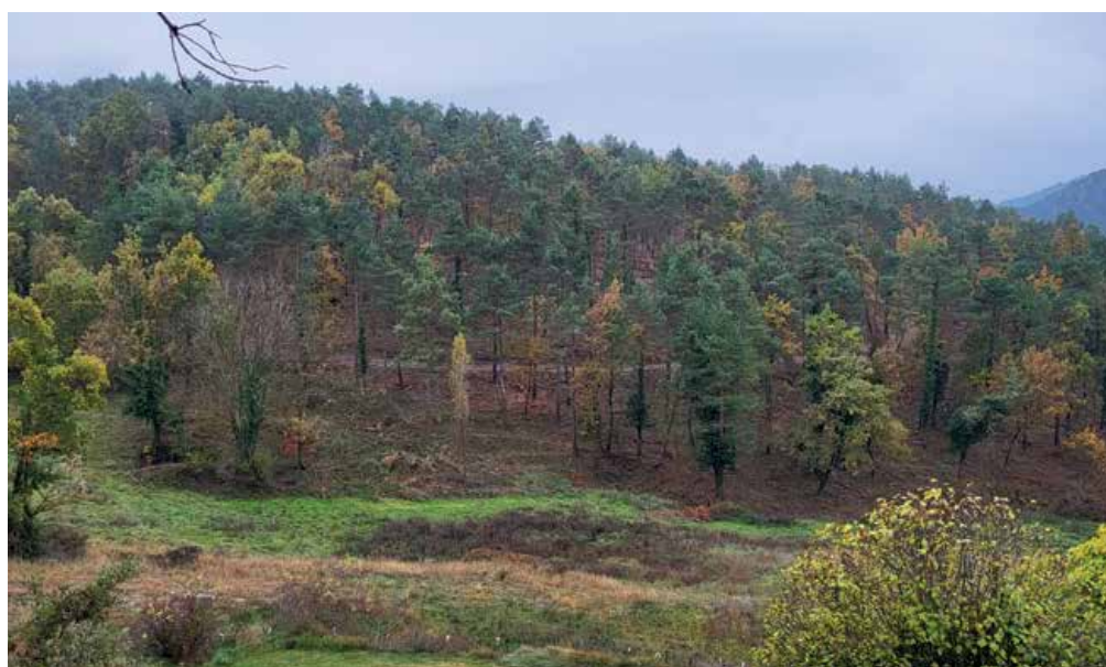
Fotografia 4. Vista general dels treballs executats.
