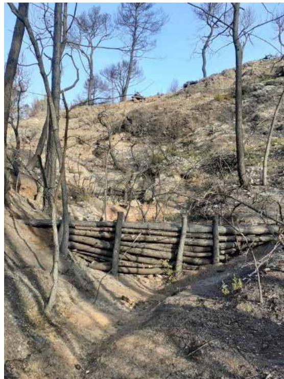
Fotografia 10. Després dels treball.
