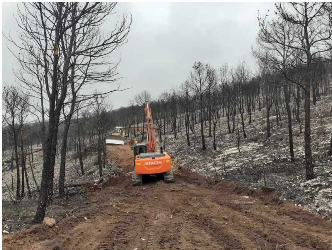
Fotografia 6. Obertura de camins de la Xarxa Viària bàsica a Sant Martí de Tous.
