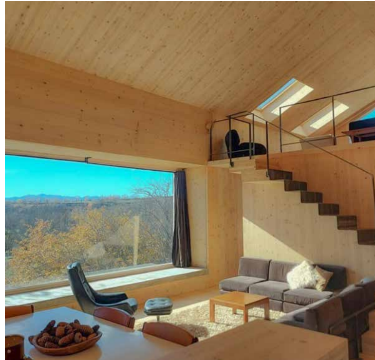
Figura 10. Interior acabat d'un habitatge basat en CLT, que fa les funcions estructurals i d'acabament alhora.
