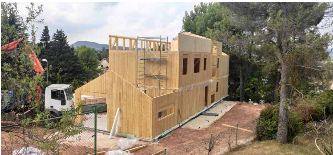
Figura 1. Habitatge en construcció emprant panells de fusta CLT que són estructurals i constructius alhora i també poden oferir l'acabament final.
