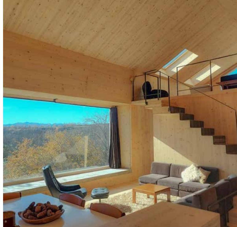
Figura 10. Interior acabado de una vivienda basada en CLT, que hace las funciones estructurales y de acabado a la vez.
