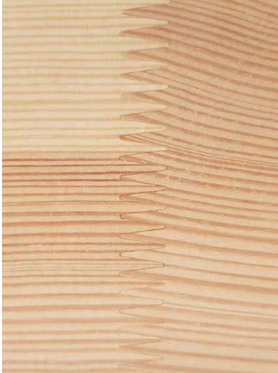
Figura 9. Detalle del fingerjoint entre dos piezas para generar una de más grande.
