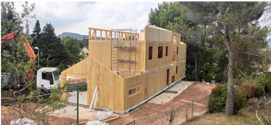
Figura 1. Vivienda en construcción empleando paneles de madera CLT que son estructurales y constructivos a la vez y también pueden ofrecer el acabado final.
