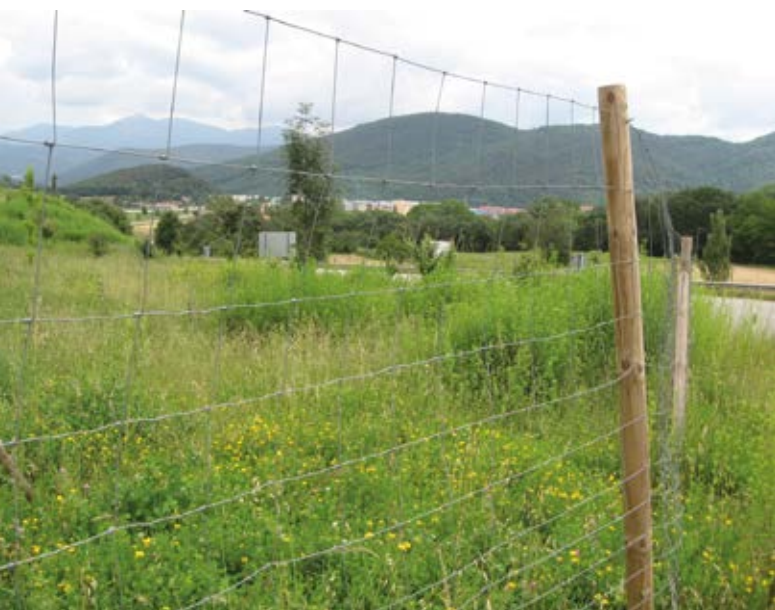
Fotografia 2. Tancament perimetral amb malla cinètica de densitat progressiva. Per ser efectiva contra senglar, cal que estigui enterrada uns 20cm a la part inferior.
