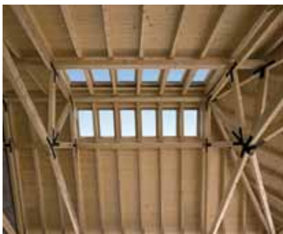
> Fotografia 7. Interior d'una coberta de fusta amb biga laminada construïda per Sebastià a Baqueira (Val d'Aran).
