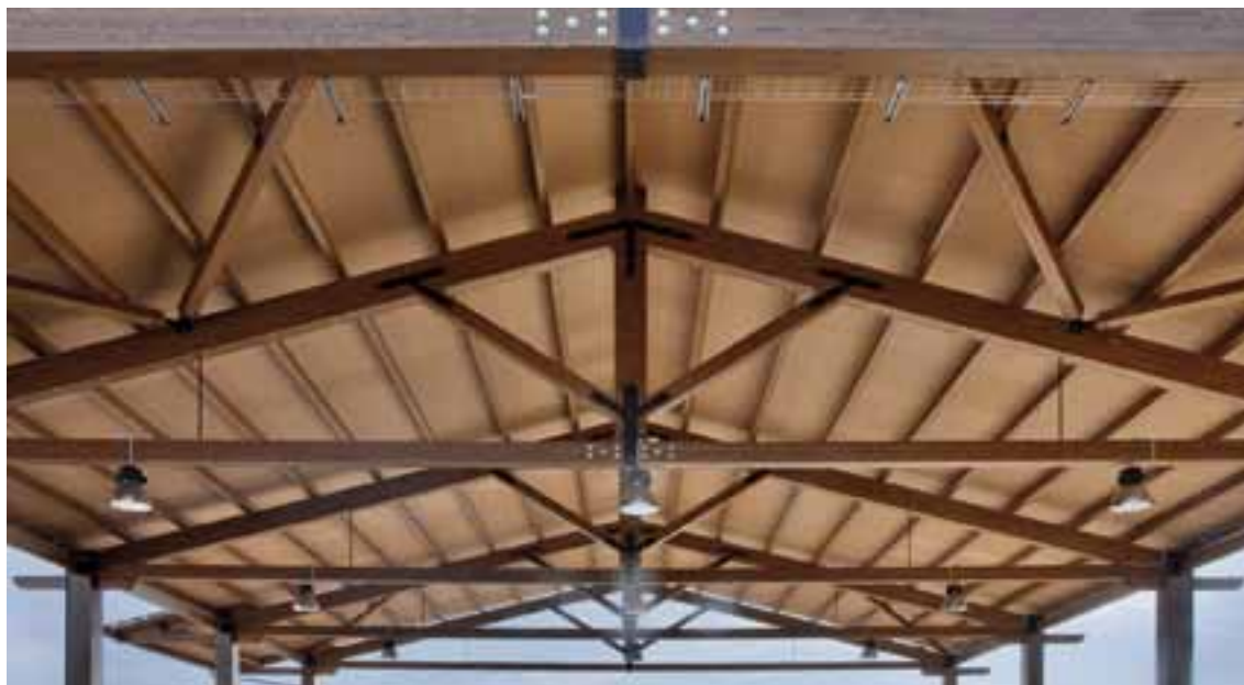
> Fotografia 1. Estructura de fusta en nau industrial formada per grans encavallades de cinc nusos.
