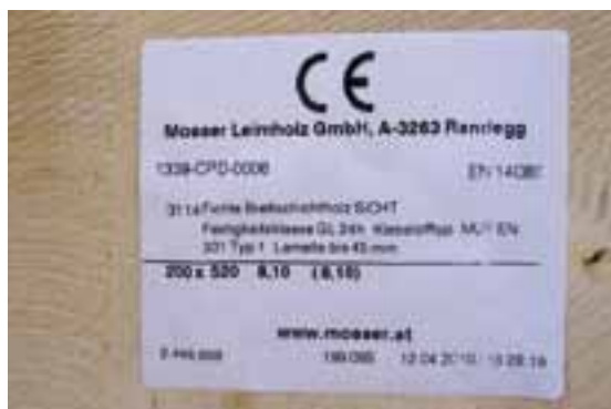
> Fotografia 3. Segell CE en un element estructural de fusta laminada procedent d'Àustria.
